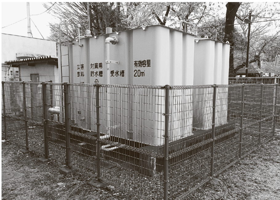
小・中学校に設置されている災害対策用の飲料貯水槽 (小平第三小学校)
