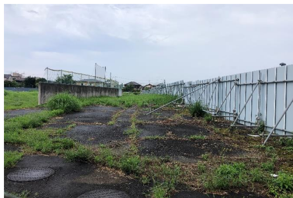
写真 2-2 ②計画地内の状況
