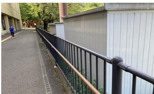
既存のフェンス
