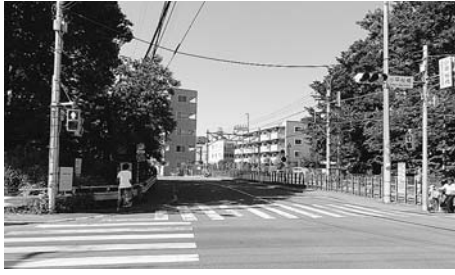
債務負担行為により改修工事を行う予定の桜橋(市道第B-94号線)
