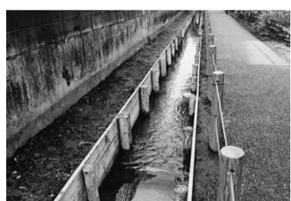
延長した水路
