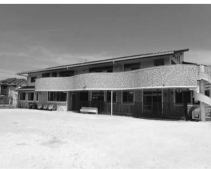
◆新設された認可保育園(花小金井にこ保育園)
