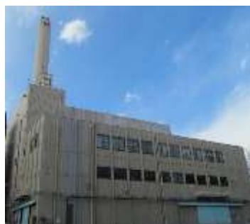
小平・村山・大和衛生組合の外観
