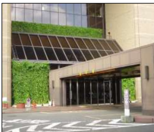
市役所正面玄関の緑のカーテン
