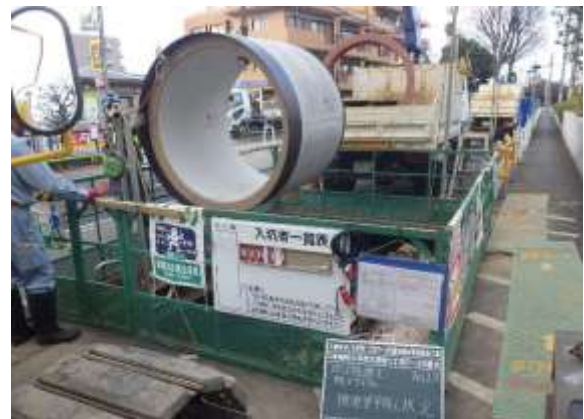
雨水管きょ整備
