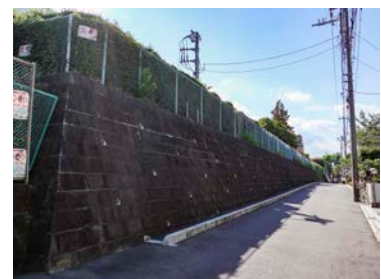
⑫：保存管理等用地 北側擁壁
