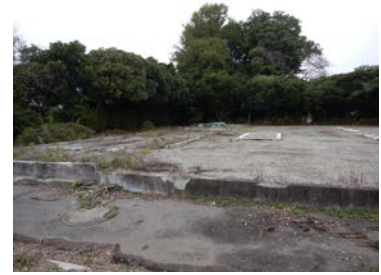
⑤：保存管理等用地内プール跡
