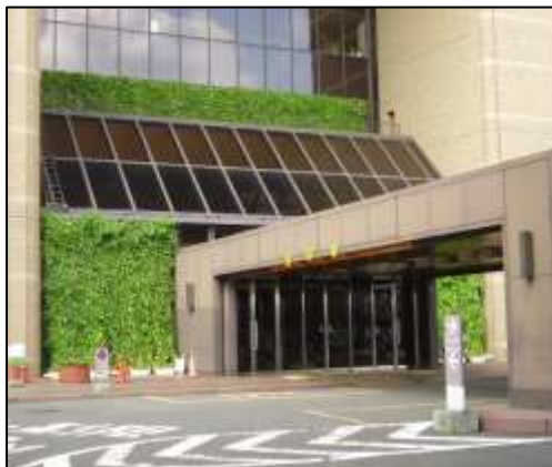
市役所正面玄関の緑のカーテン
