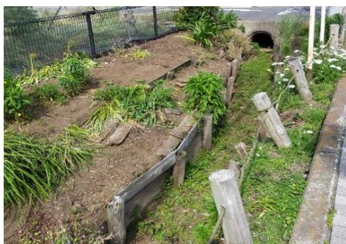
親水整備した箇所の劣化状況（施工前）
