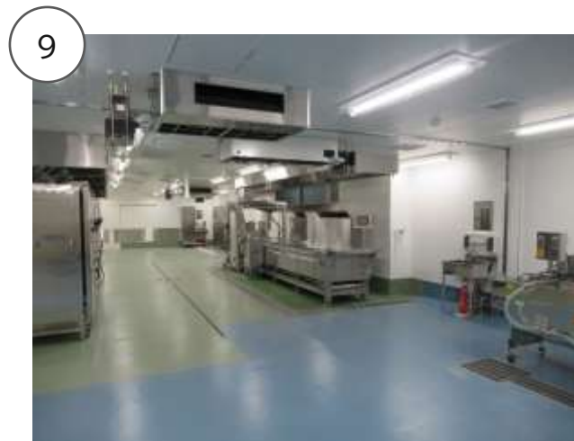
揚げ焼き室(1階)
