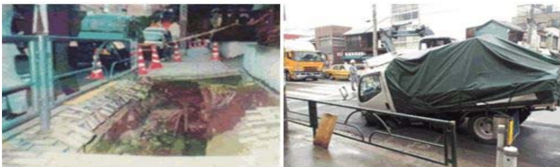
図 1.2 下水道施設に起因した道路陥没状況
