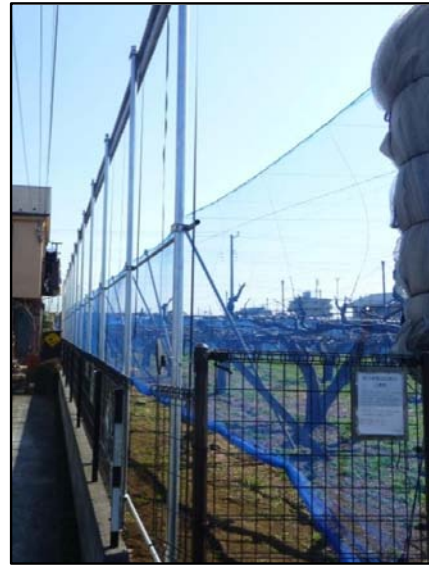
平成27年度に設置された防薬シャッター
