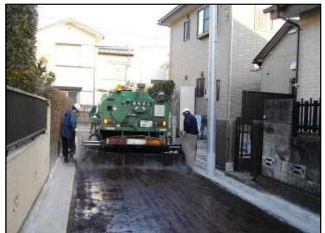
道路新設改良工事の様子
