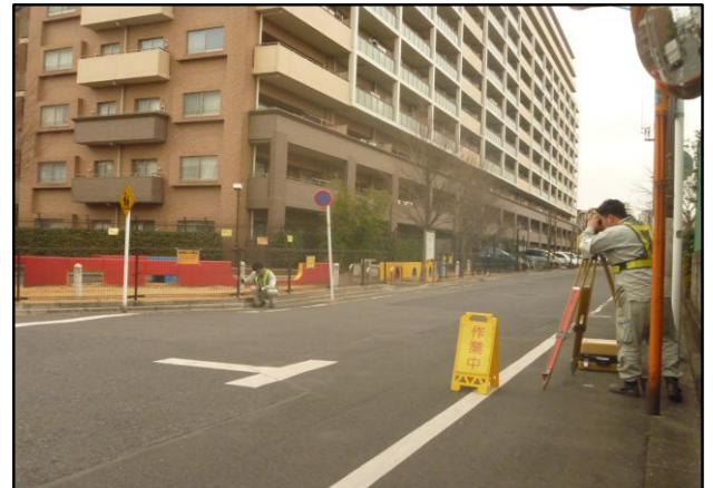
平成27年度に実施した先行調査の様子
