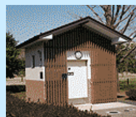
トイレの設置
