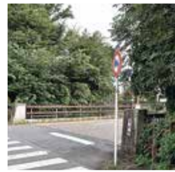
貫井橋の様子 令和4年撮影
