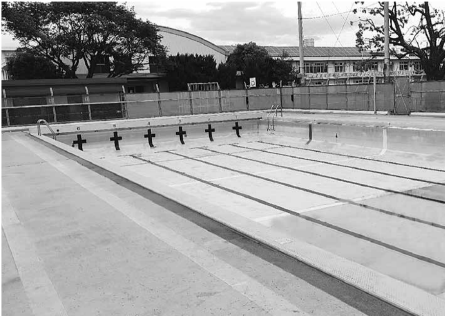
改修が予定されている小平第十二小学校のプール
