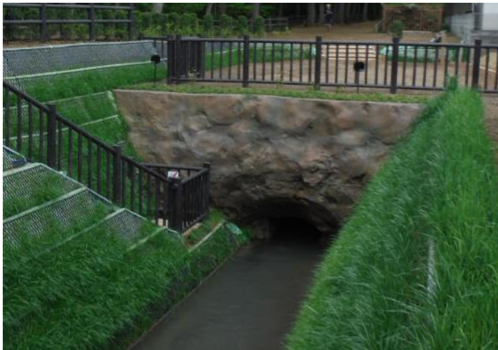
胎内堀補強工事(下流部)
