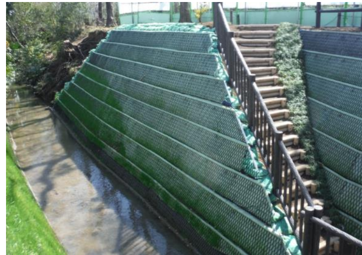
新堀用水の法面補強工事
