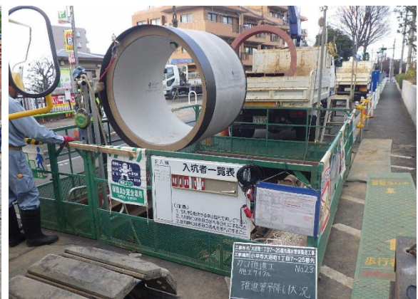
雨水管きょ整備
