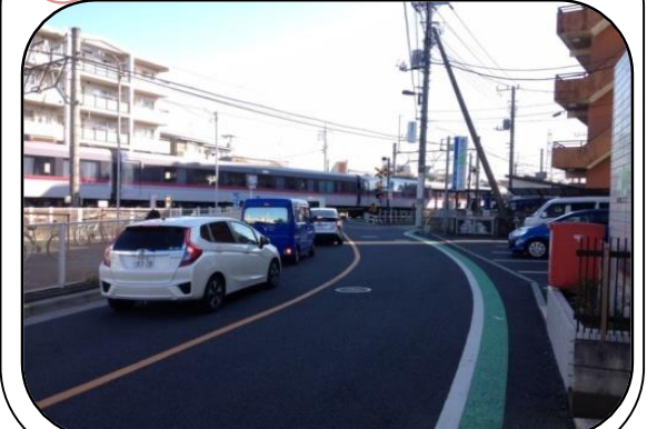
⑤（都道132号：至西東京市）
