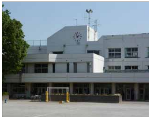
大規模改造工事を実施する四小の校舎
