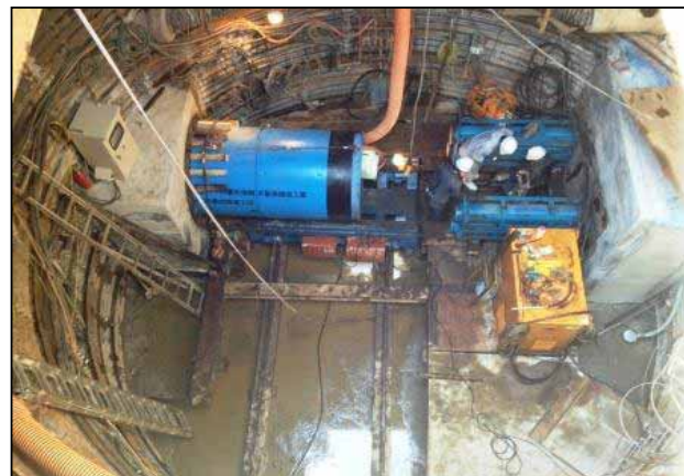
雨水管きょ築造工事の立坑内部
