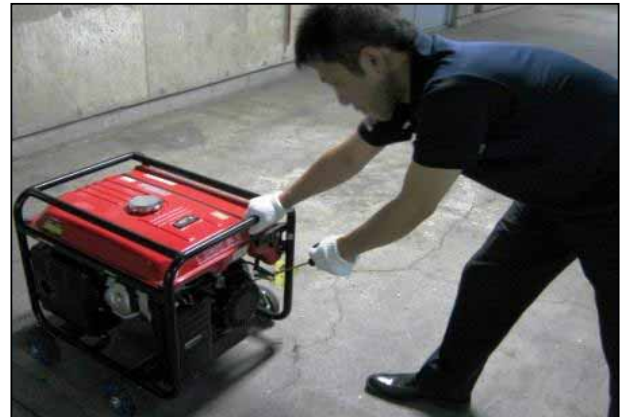
発電機を始動させる様子
