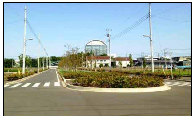
小川町一丁目土地区画整理事業地内の3・3・3号線整備状況
