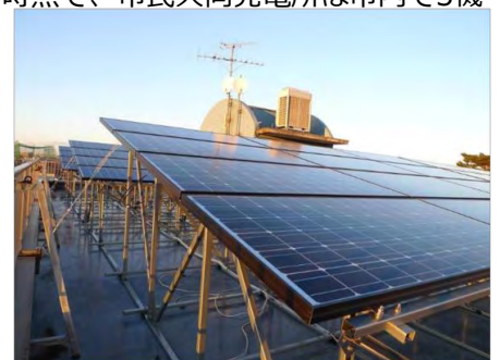
市民共同発電所第1号機
