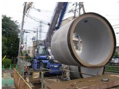
写真2-5 雨水管きよ整備状況
