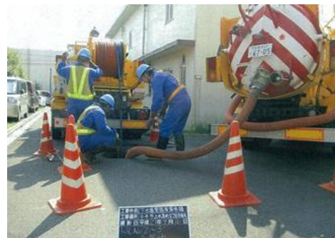
管きよの清掃状況
