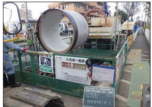
雨水管きよ築造工事の様子
