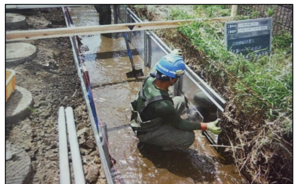
護岸修繕の様子
