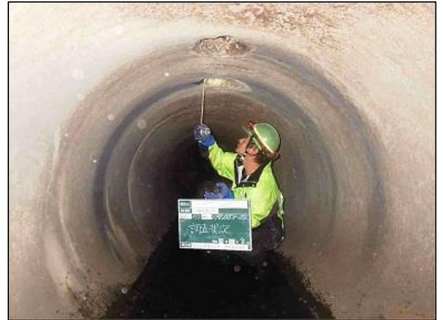
下水道管きよの調査の様子
