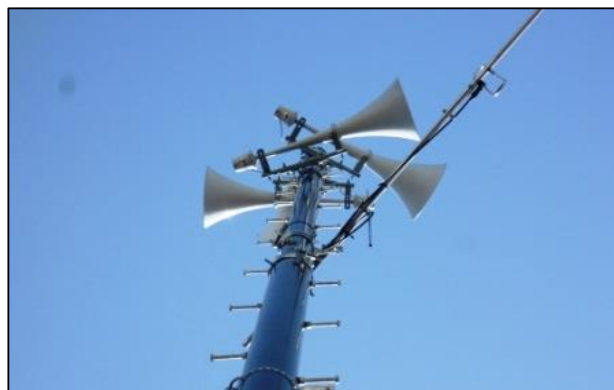
デジタル化改修する防災行政無線
