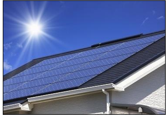
太陽光発電設備
