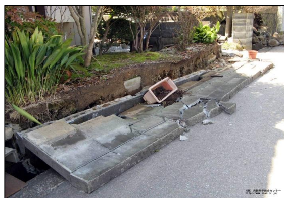
ブロック塀倒壊事例（出典：(財)消防科学総合センター）
