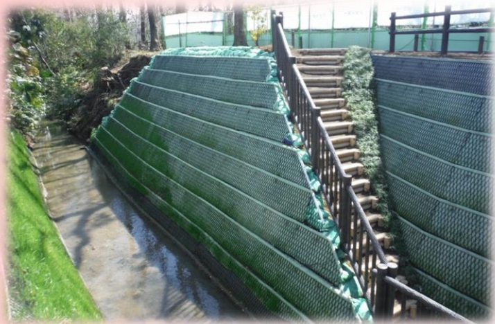
新堀用水のり面（胎内堀）保全整備 （小川橋西側付近）
