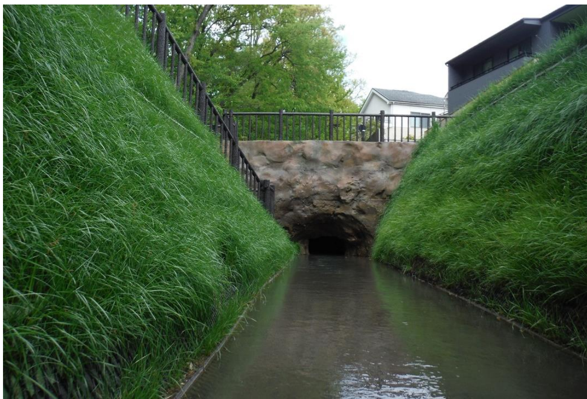
新堀用水のり面（胎内掘）保全整備（小川橋西側付近）
