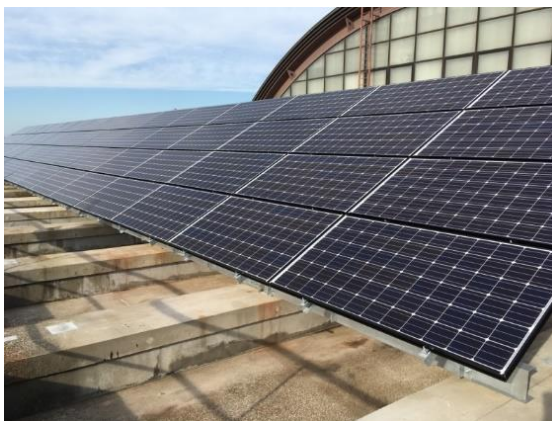
太陽光発電設備(市民総合体育館)
