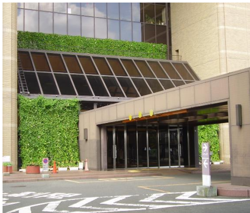
市役所正面玄関の緑のカーテン
