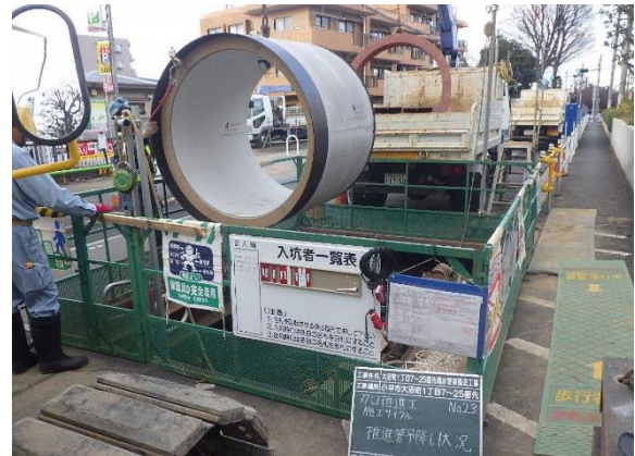
雨水管きょ整備
