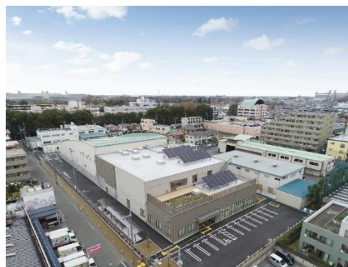
リサイクルセンター全景
