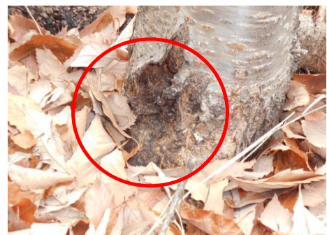
No.2南側根際の損傷状況 平成30年3月10日撮影
