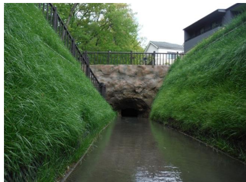
新堀用水のり面(胎内堀)
