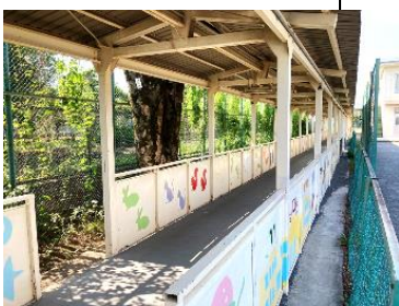
体育館渡り廊下
