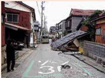
能登半島地震で倒壊した木造住宅
