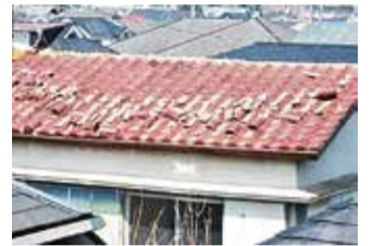
地震による屋根瓦の破損
